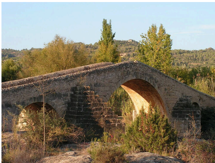
Imagen del Puente Viejo de este pueblo perteneciente a la comarca de El Priorat, Cataluña (Flickr)
